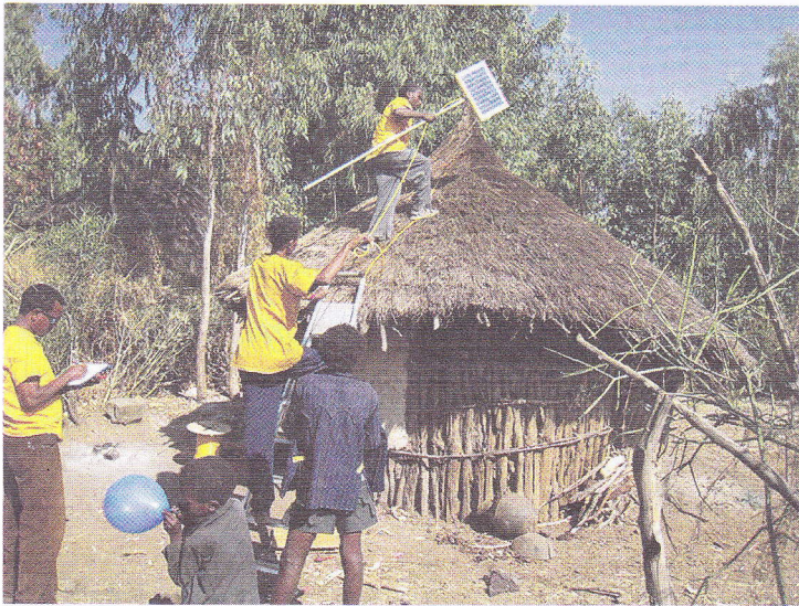
Kompensationsprojekt in Kenia / Äthiopien: Solarpanels und LED-Leuchten statt rußiger Kerosinlampen, kombiniert mit einem Ausbildungsprojekt zum Solartechniker.
